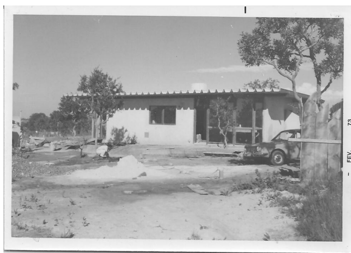
Fundos da casa, o Corcel 71 e o banheiro de tábuas para banho de mangueira.02/1973
