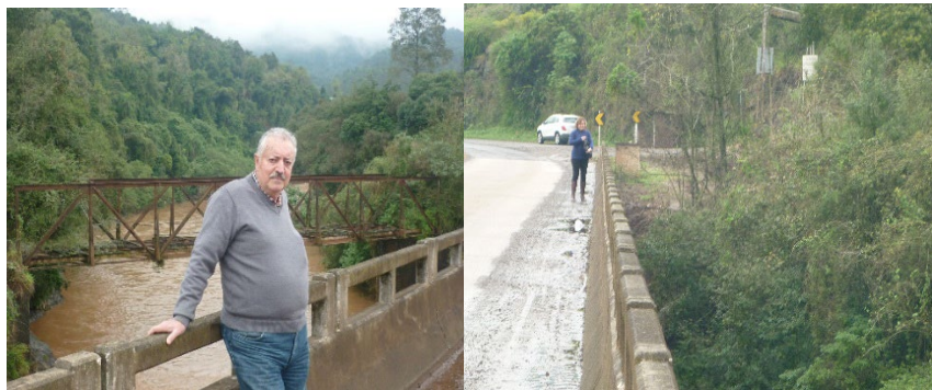
Ponte do avo João, ao fundo, e a de concreto da estrada que vai a Encantado
